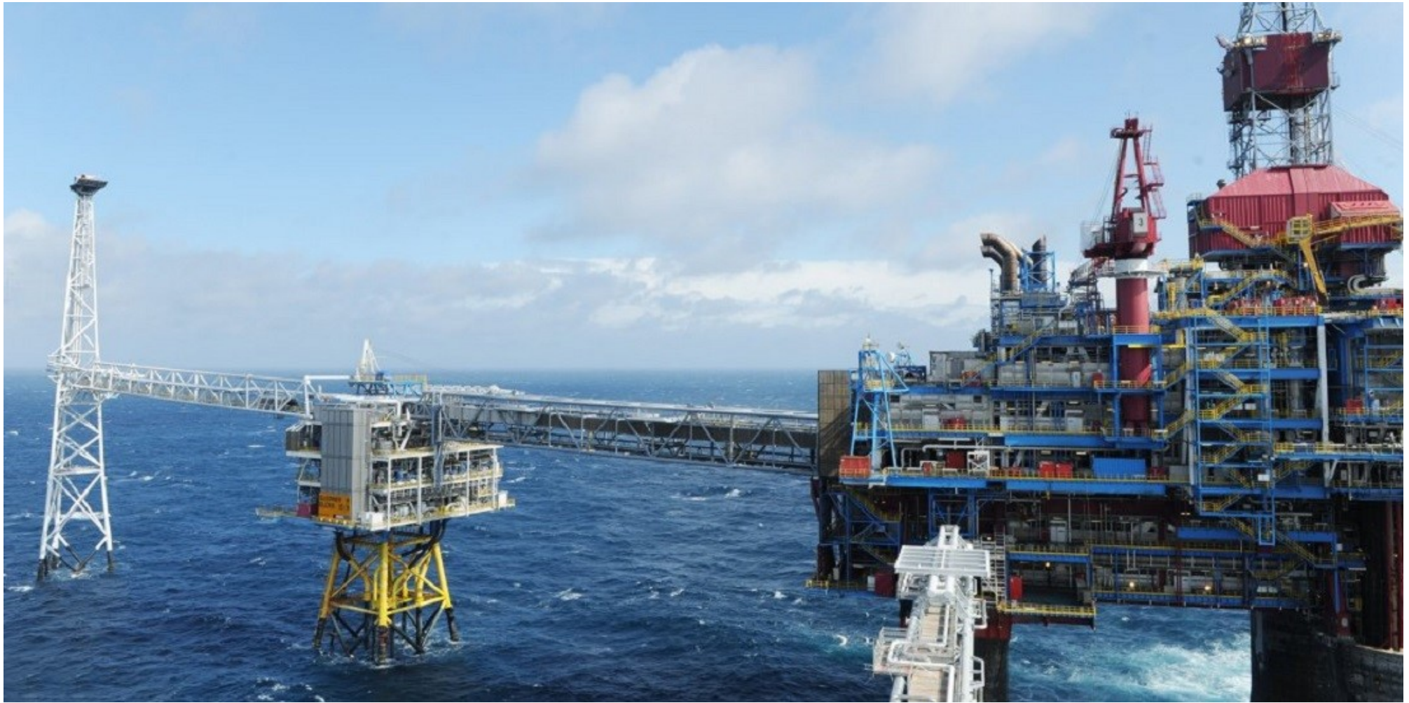
Sleipner-feltet i Nordsjøen. Her har Equinor injisert CO2 i havbunnen i over 20 år. Foto: Equinor
